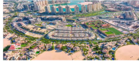
جاردينو فيلاج - عمليات المرافق السكنية
