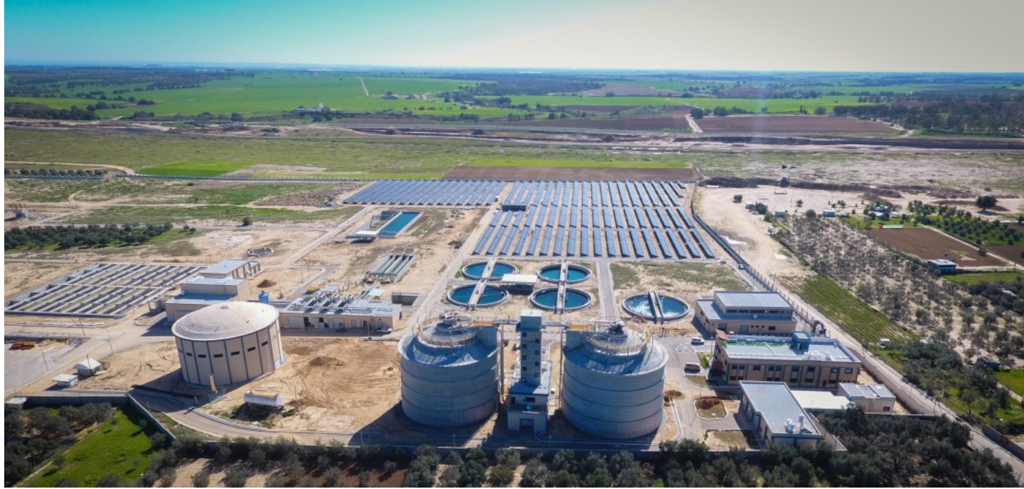
في غزة محطة معالجة مياه الصرف الصحي
